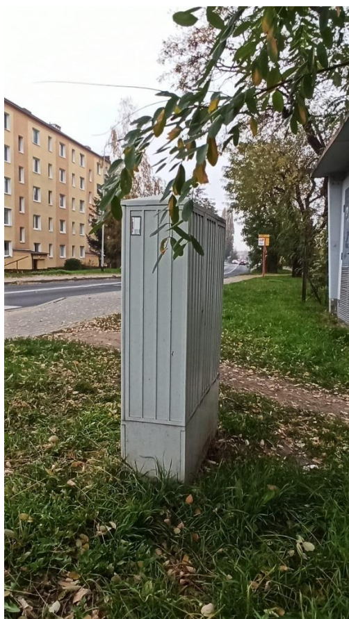
Szafki oświetlenia ulicznego z zamontowanym sterownikiem – ul. Jałowcowa, ul. Przemysłowa
