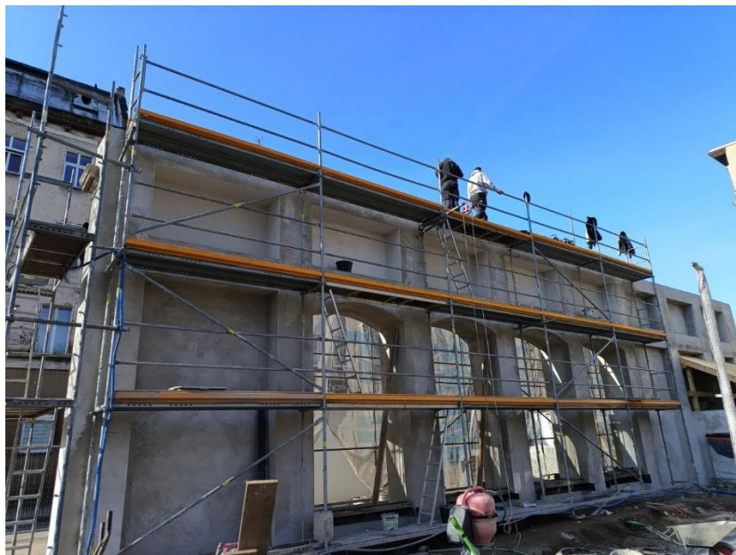
Ogródek Jordanowski – roboty budowlane przy ścianie kurtynowej
