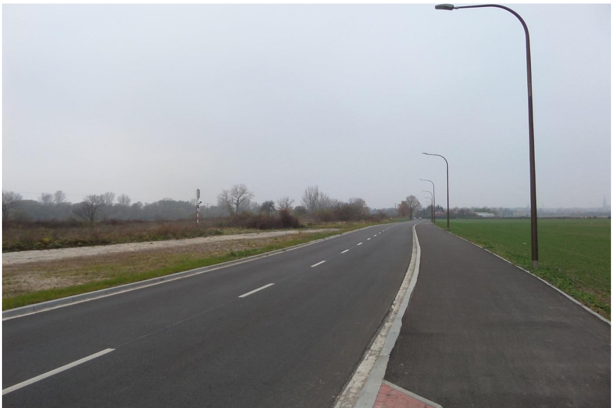
Ul. Kraszowicka po przebudowie
