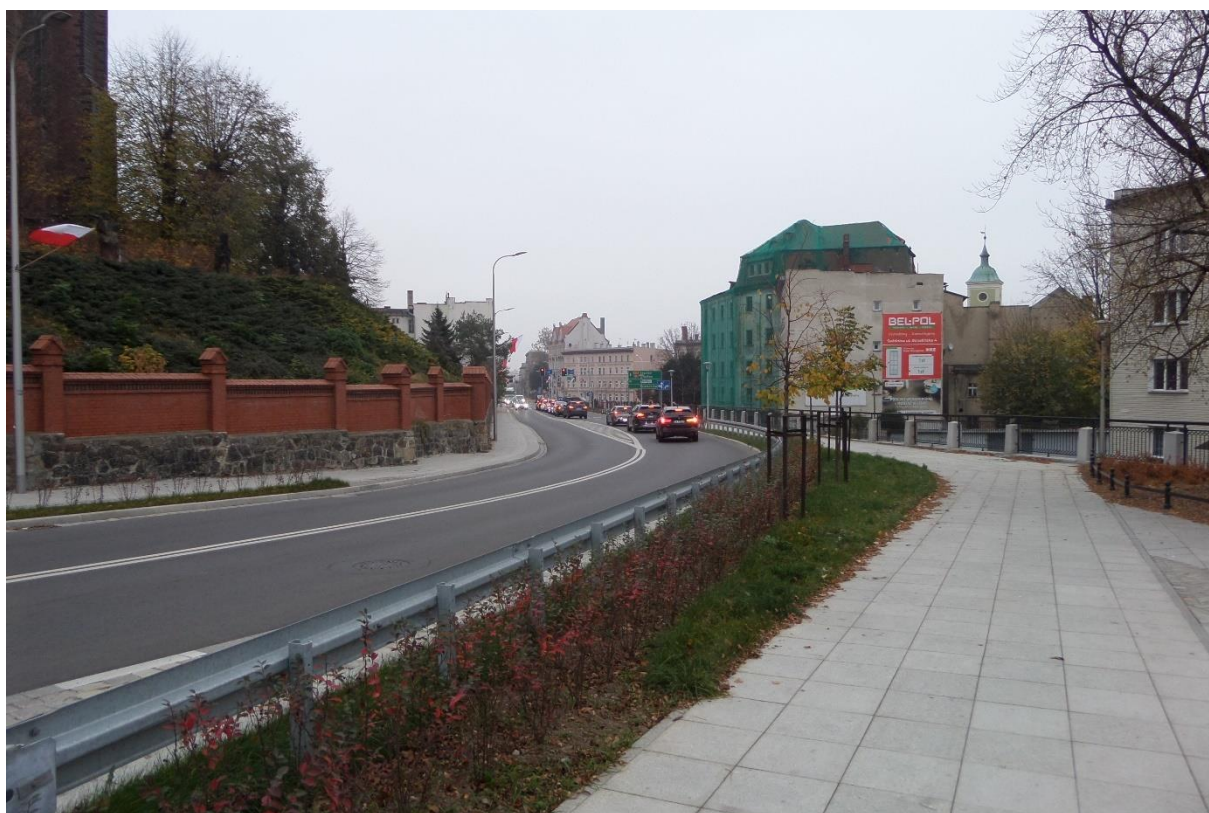
Al. Niepodległości po przebudowie
