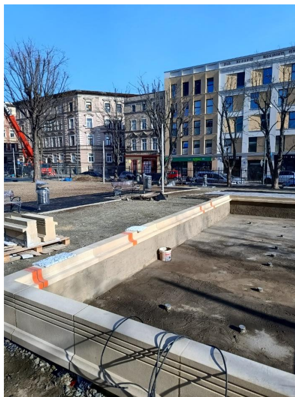
Ogródek Jordanowski – budowa fontanny
