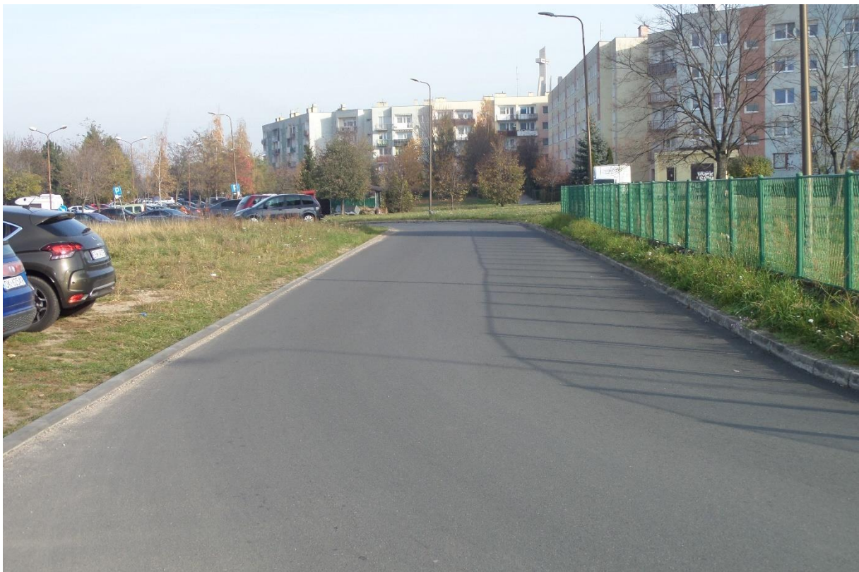
Wykonana wymiana warstwy ścieralnej ul. Prądzyńskiego
