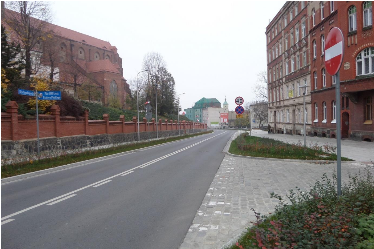
Al. Niepodległości po przebudowie
