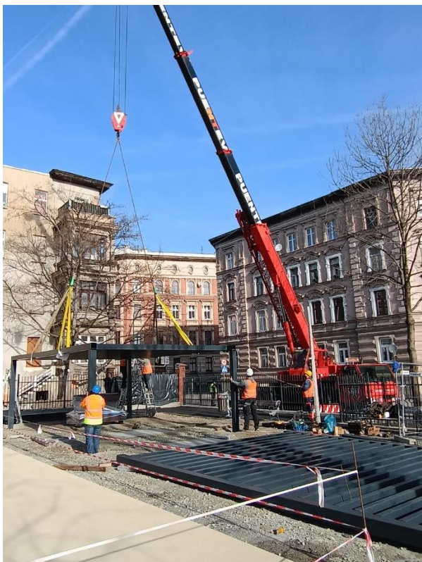
Ogródek Jordanowski – montaż pergoli
